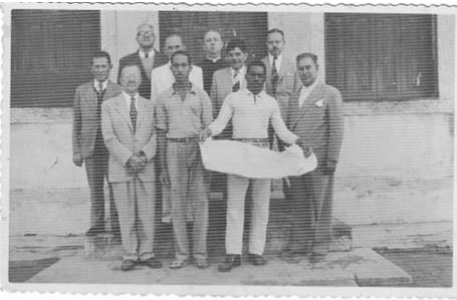
Início das Obras na Matriz - 22 de Junho de 1953
